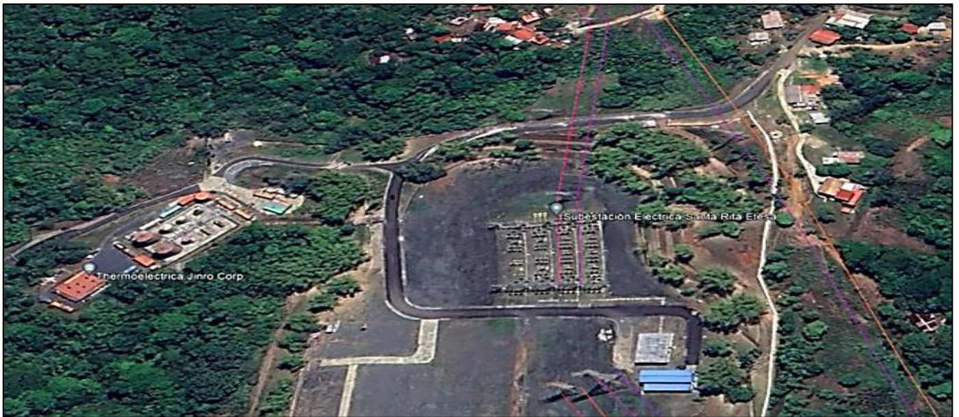
Figura 5: Ubicación geográfica del proyecto “Adición de Bancos de Capacitores de 40 MVAR en Subestación Santa Rita 115 kV”
